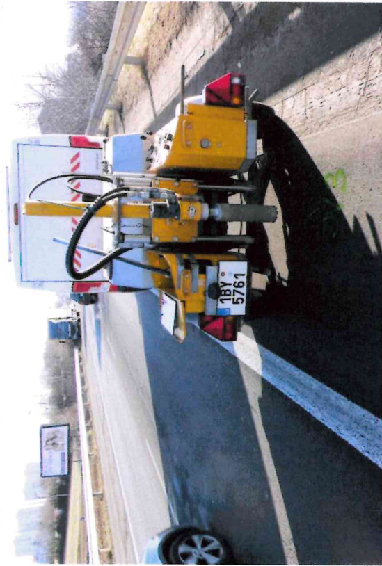
Foto č. 7 – Detail místa odběru vývrtnu JV 3
